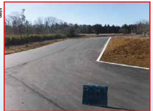
新設した防火帯 (外部からの火災の延焼防止対策)
